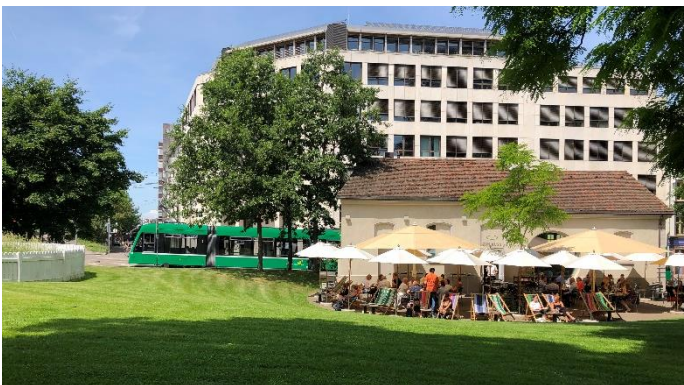
Abbildung 7: Beispiel für eine Gestaltung einer tramgleisnahen Fläche im Umfeld mit kleinmassstäblicheren Bauten (Café Zum Kuss, Basel).Quelle: Pe, TBA BL
