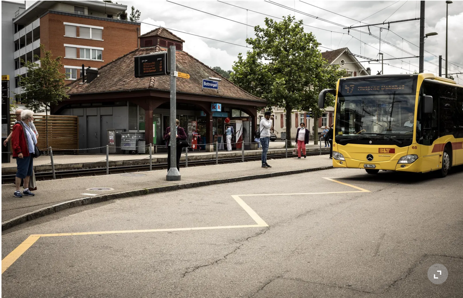
Die Haltestelle Bottmingen Dorf soll umfassend saniert werden.
